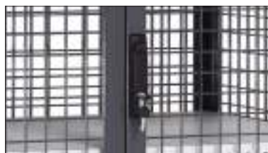
Spanjoetsluiting met zwenkhandel en cilinderslot.
