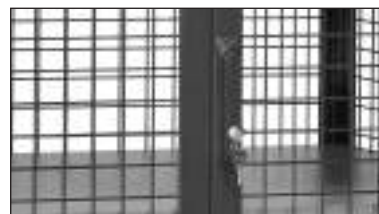
Spanjoletsluiting met zwenkhandel en cilinderslot.
